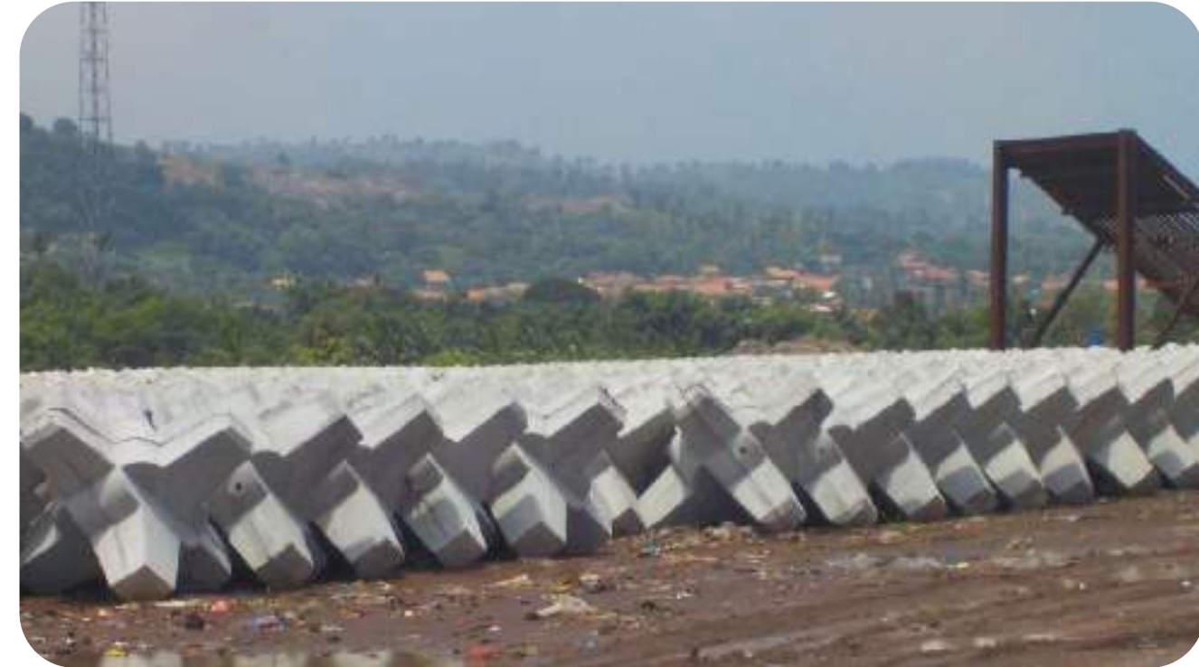
Implementasi breakwater "A-JACK" di Pelabuhan.
