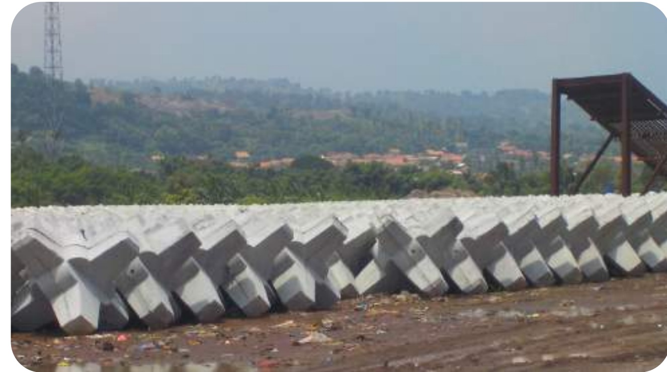
Implementasi breakwater "A-JACK" di Pelabuhan.
